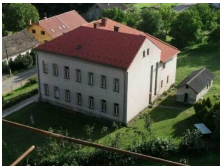
Škola před rekonstrukcí
