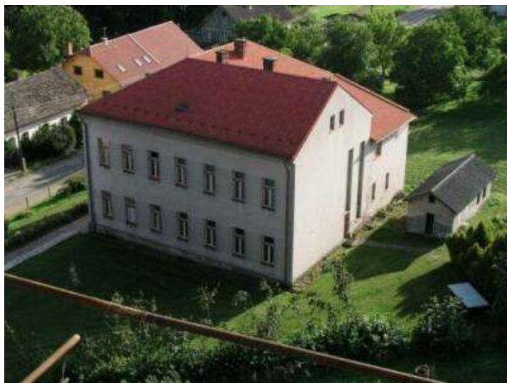
škola před rekonstrukcí
