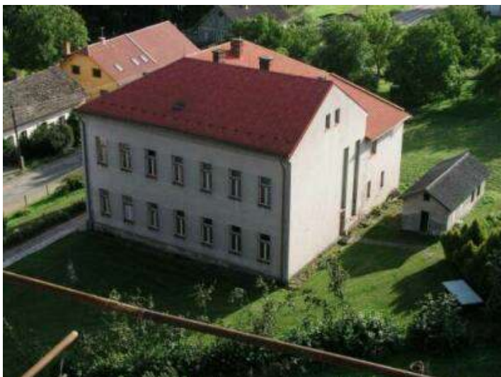
škola před rekonstrukcí
